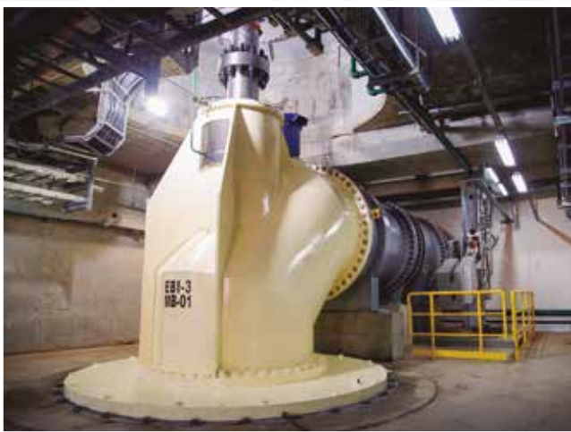
As motobombas deverão dobrar a capacidade de bombeamento do chamado Eixo Norte da iniciativa, buscando ampliar a oferta de água para populações de quatro estados do Nordeste
