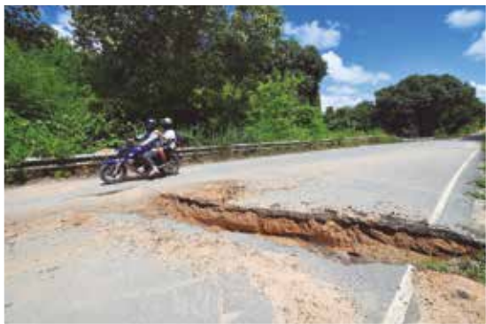
Ruptura em elementos estruturais da ponte sobre o Rio Papocas foi causada pelas chuvas de janeiro deste ano e ameaça a segurança dos moradores
