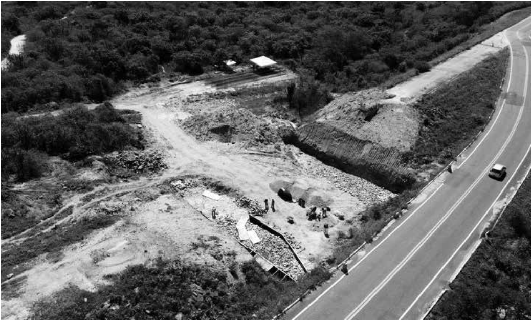
A etapa atual da OEA é a de instalação das vigas e levantamento do muro de contenção
