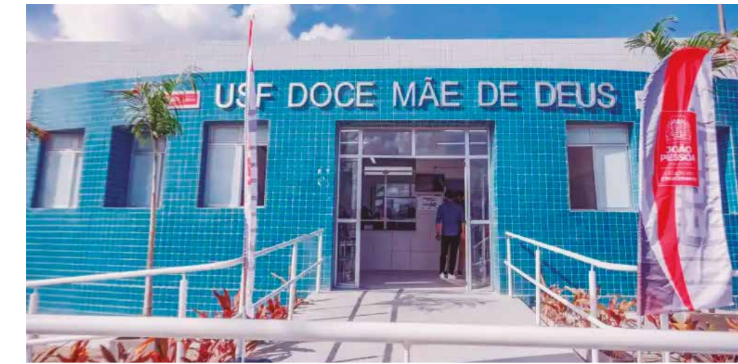
A reforma da unidade possibilita maior conforto às pessoas da comunidade que utilizam o espaço
