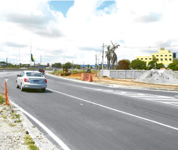
Serviço de terraplanagem também está sendo feito em via lateral
