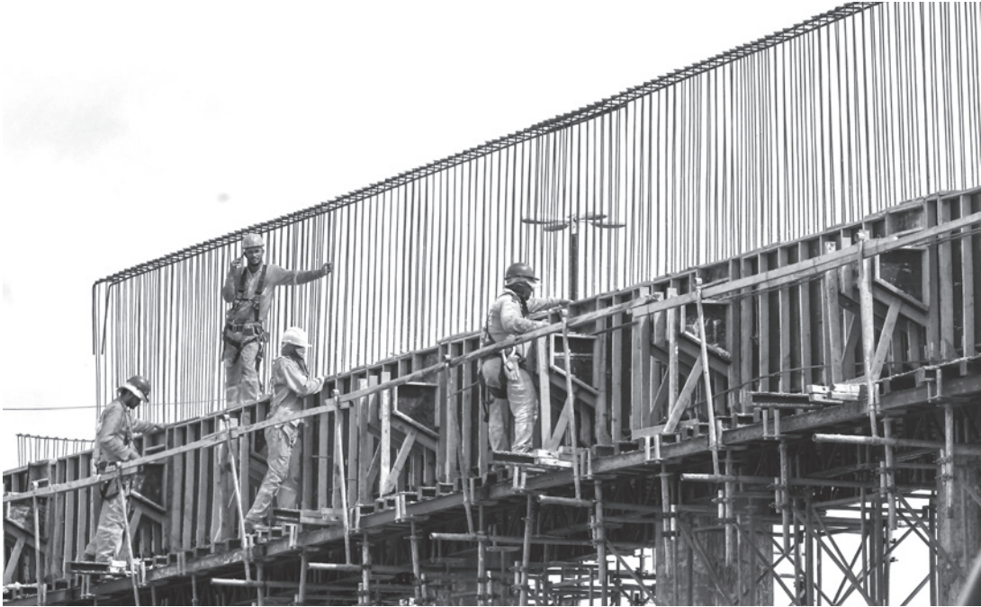
A infraestrutura em construção
