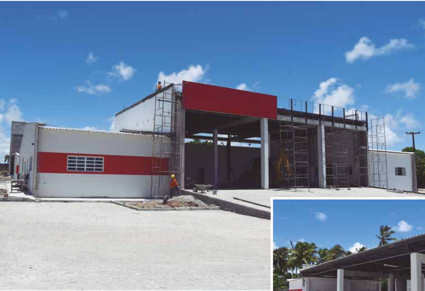
Empreendimento de 1.400 m², no bairro de Jacarapé, está 90% concluído e deve ser entregue em abril, com investimento superior a R$ 6 milhões; no segundo bloco, ficarão, entre outras acomodações, o depósito e a garagem
